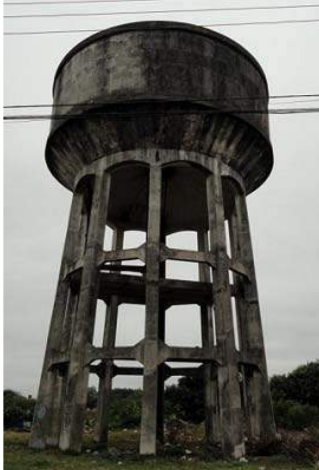
Ilustração 05 – Vista frontal do Reservatório R7.
