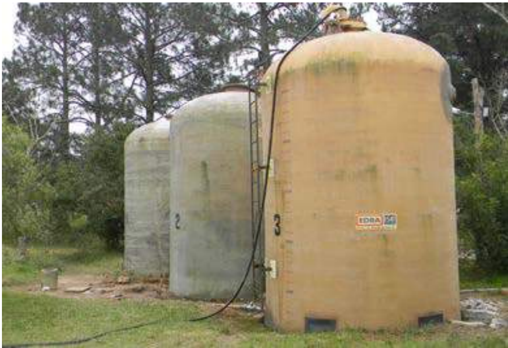
Ilustração 42 – Tanques de PAC
