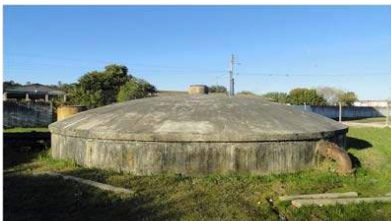
Ilustração 09 – Vista frontal do Reservatório inferior, semi-enterrado.
