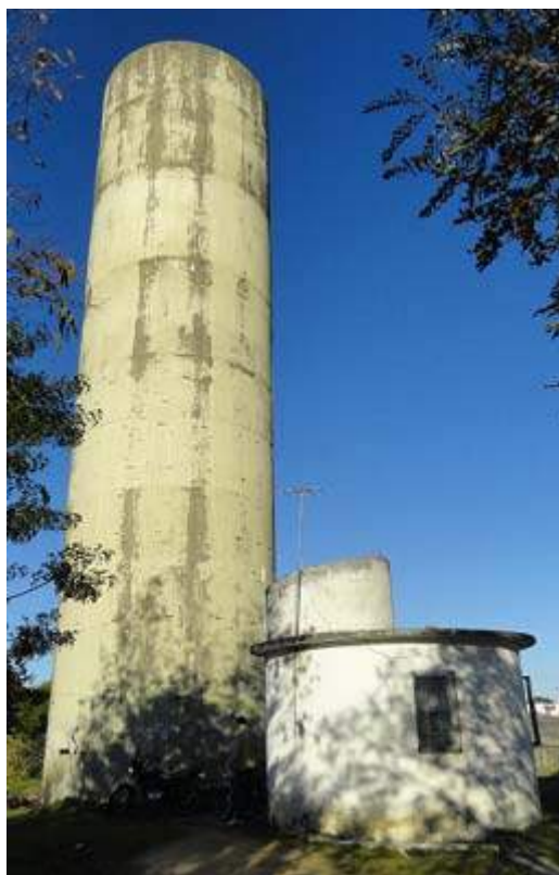
Ilustração 08 – Vista frontal do Reservatório Lindóia.
