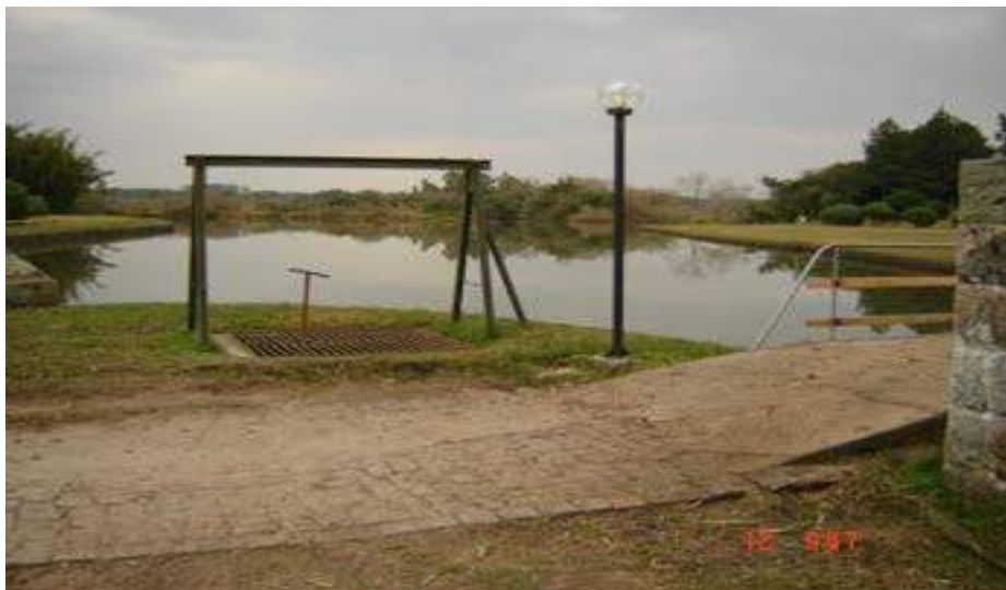
Ilustração 3 - Tomada de água bruta ETA Moreira
