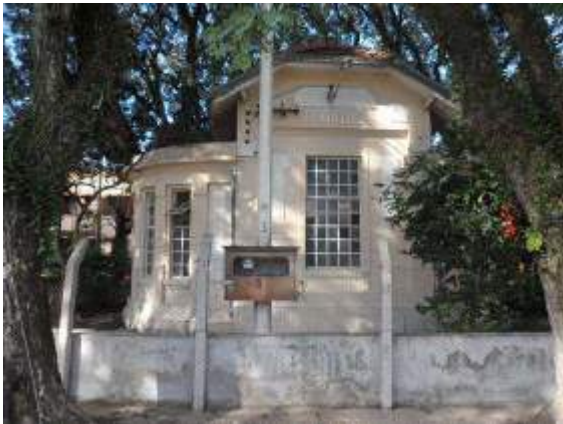
Elevatória Saldanha Marinho US-II. (Fonte SANEP)
