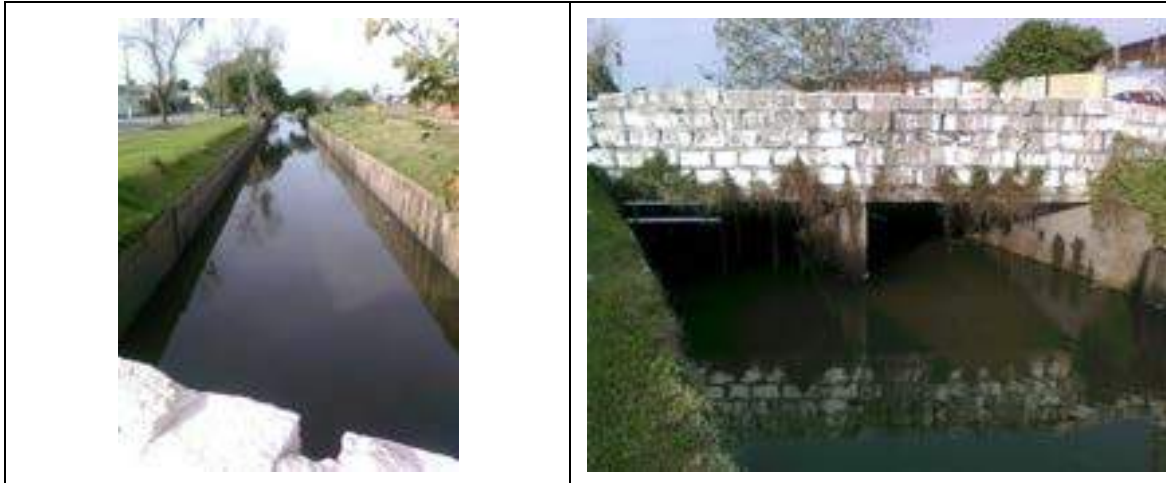
Figura 14: Canal do Arroio Pepino - Avenida Juscelino Kubitschek com General Neto
