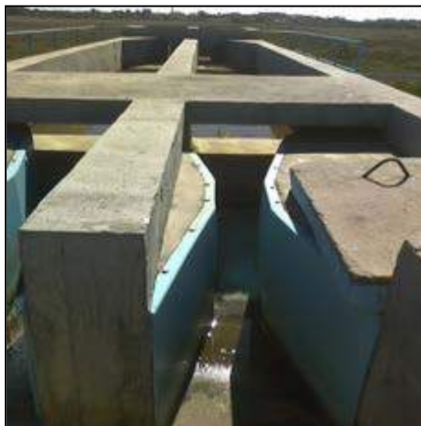
Figura 27 - Calhas Parshall (Fonte STE)
