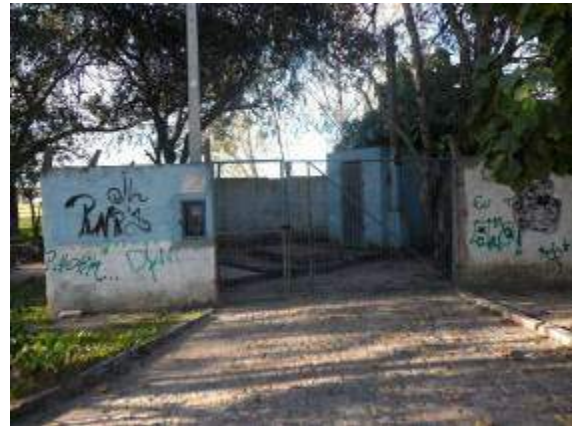
Quadro de comando ELE – Ambrósio Perret. (Fonte SANEP)
