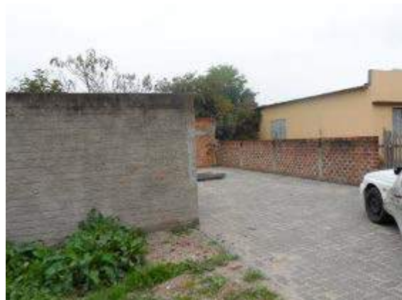
Entrada ELE – Toussaint (desativada). (Fonte SANEP)
