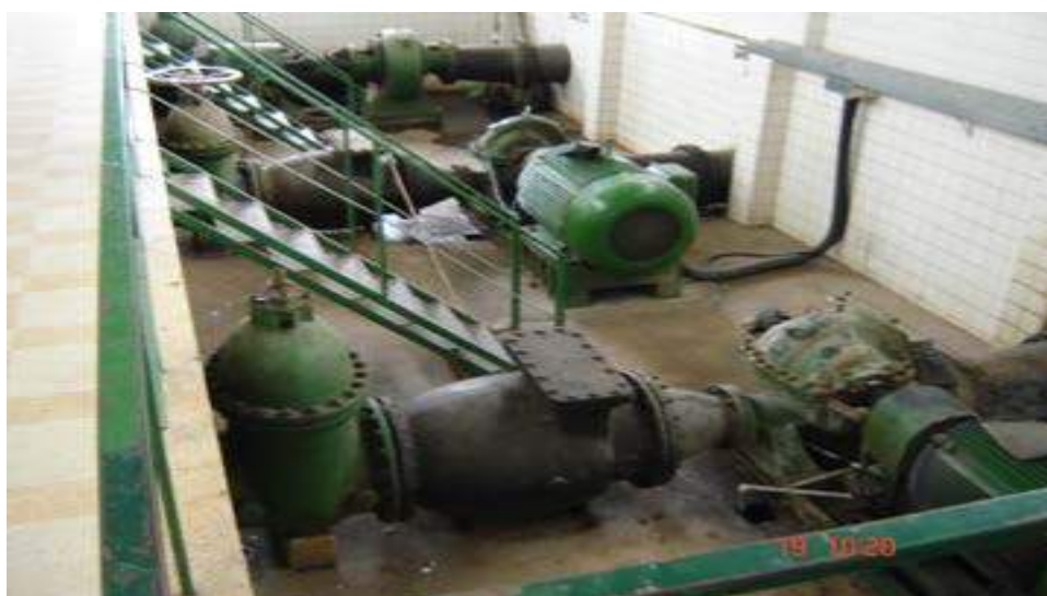
Ilustração 48 - Vista parcial da casa de bombas
