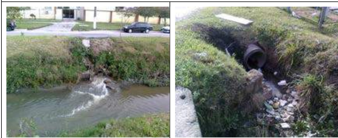
Figura 12: Microdrenagem descarregando na macrodrenagem
