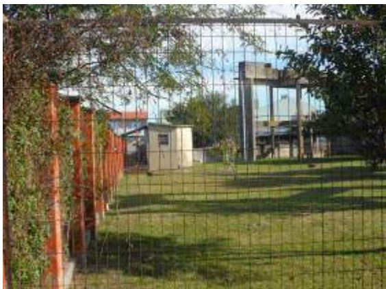
Local da Elevatória Jardim das Tradições. (Fonte SANEP)
