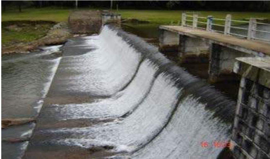
Ilustração 19 - Represa do Quilombo vendo-se no primeiro plano, peça de acionamento das comportas e no fundo a estrutura de contenção empuxos de terra.
