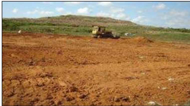
Figura 3.1 – Obras de terraplenagem e impermeabilização da base do aterro
