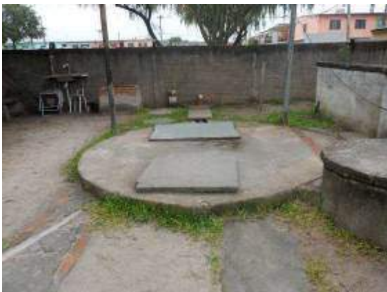
Local da Elevatória Guabiroba . (Fonte SANEP)
