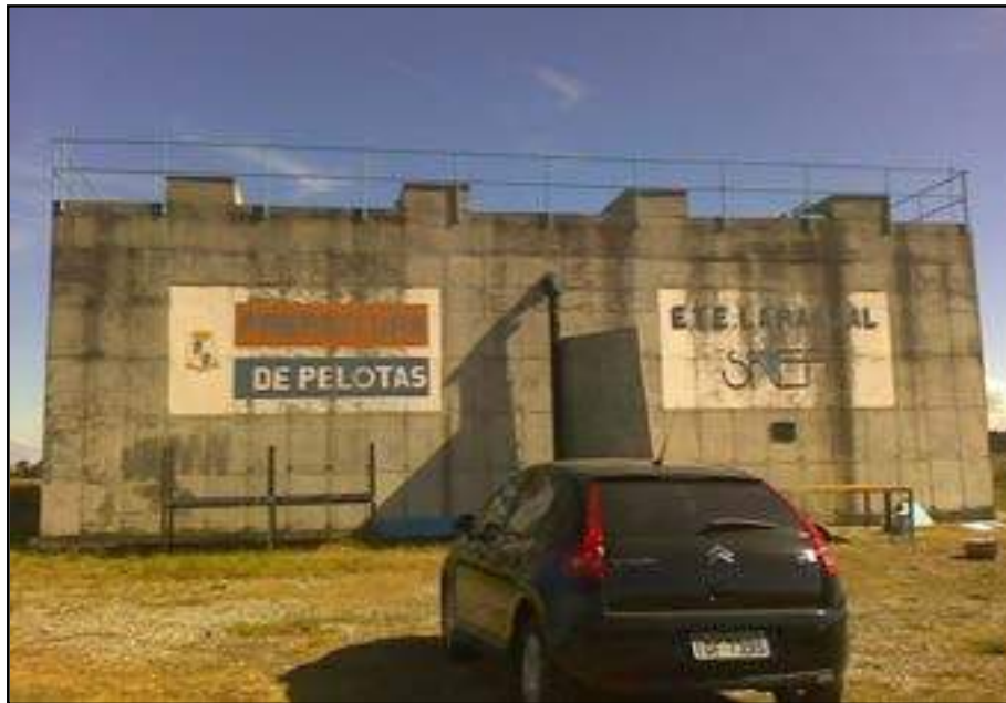
Figura 28 – Reator anaeróbio (Fonte STE)
