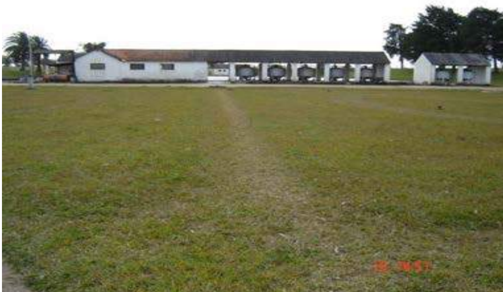
Ilustração 28 - Local do reservatório enterrado com 8.000m 3
