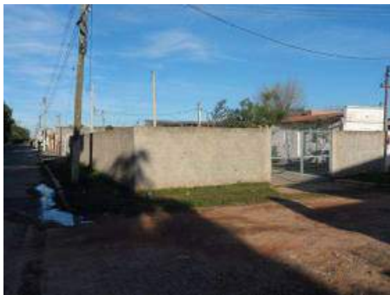
Local da Elevatória Navegantes. (Fonte SANEP)
