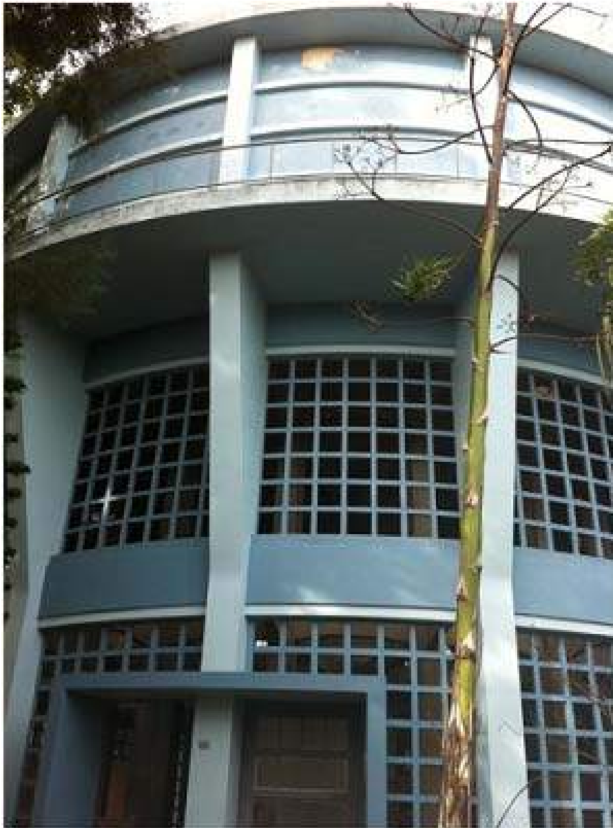
Ilustração 02 – Vista frontal do Reservatório R4.
