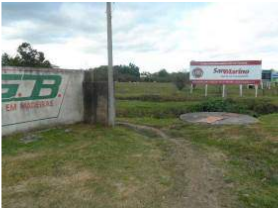
Local da Elevatória Ceval. (Fonte SANEP)
