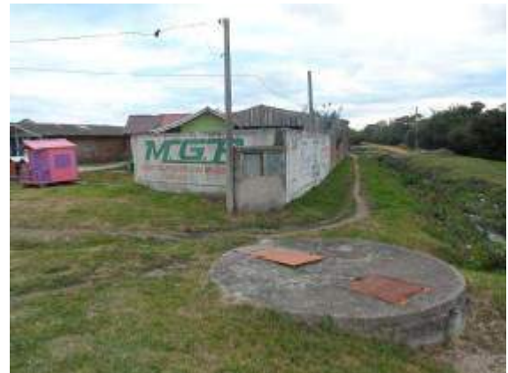
Quadro de comando ELE – Ceval. (Fonte SANEP)
