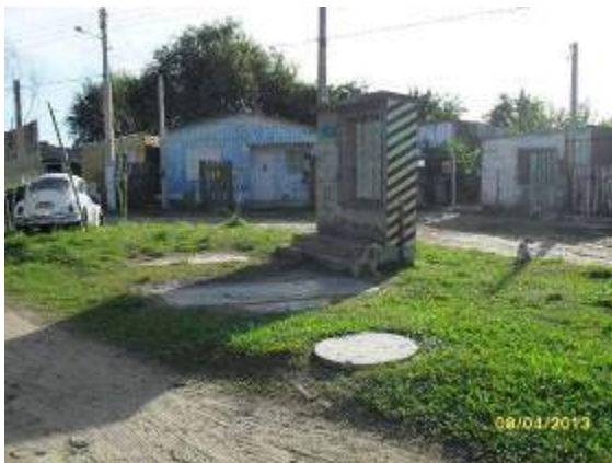
Local da Elevatória L4. (Fonte SANEP)
