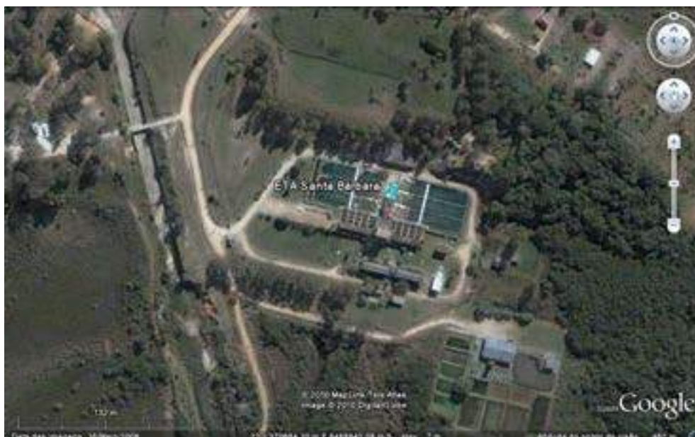
Ilustração 34 – Vista da ETA Santa Barbara
