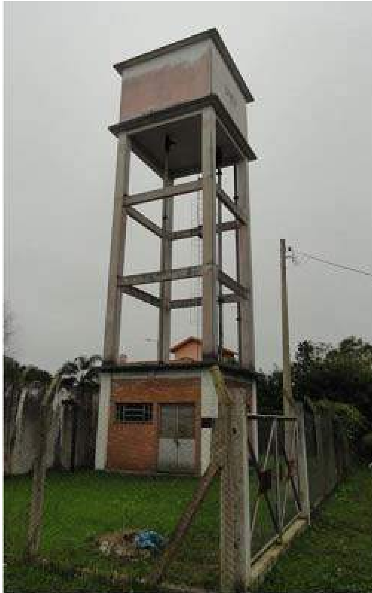
Ilustração 014 – Vista frontal do Reservatório localizado no Bairro Recanto de Portugal.
