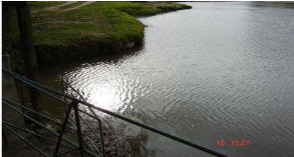
Ilustração 16 - Tomada de água Arroio Pelotas
