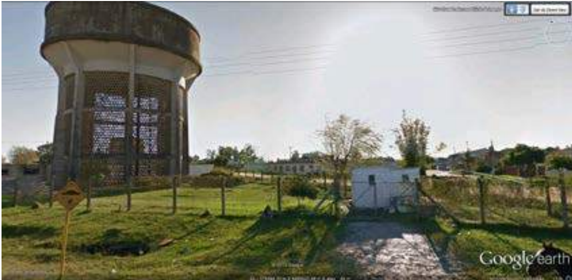
Local da Elevatória Jardim Europa (ELE - R8, ELE - 08) - (Fonte Google)
