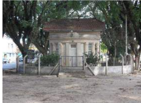
Local da Elevatória Saldanha Marinho US-II. (Fonte SANEP)
