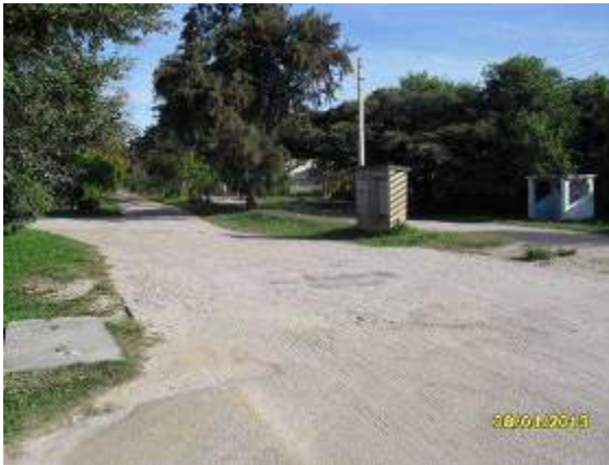
Local da Elevatória L1. (Fonte SANEP)
