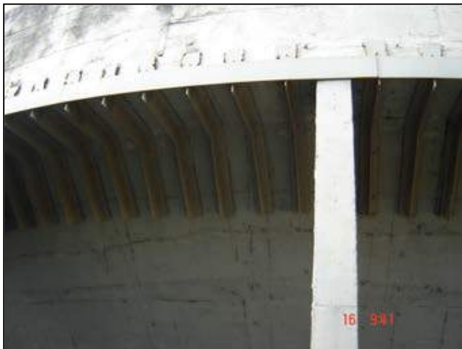
Figura 23 - Reforço estrutural nos reatores necessitando de manutenção (Fonte STE)
