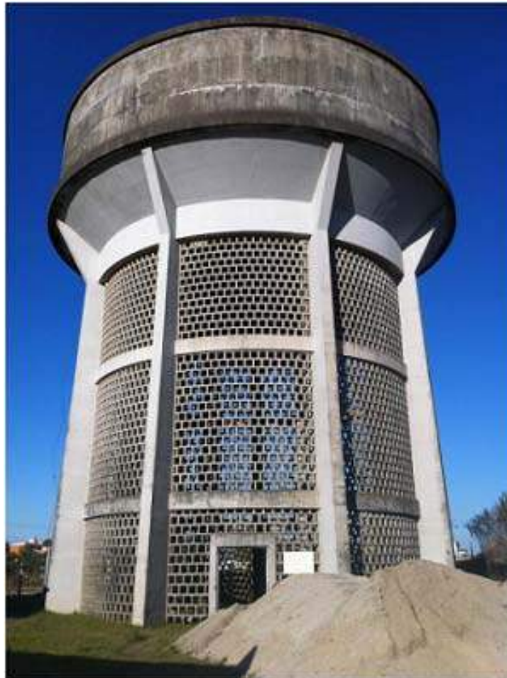
Ilustração 04 – Vista frontal do Reservatório R8.
