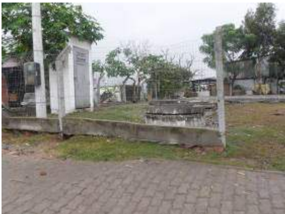
Local da Elevatória Ceval. (Fonte SANEP)
