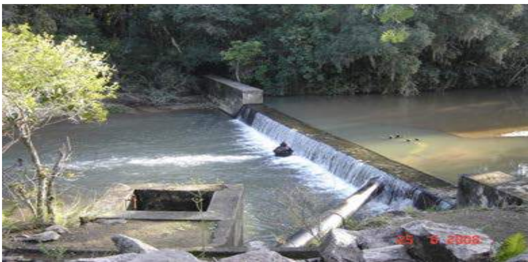
Ilustração 21 - Represinha com vista da captação
