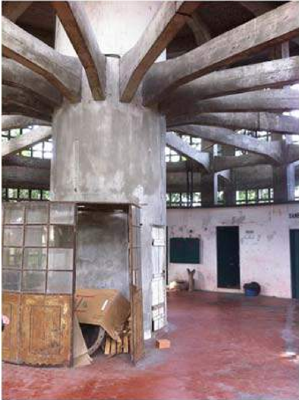
Ilustração 03 – Interior do Reservatório R4.
