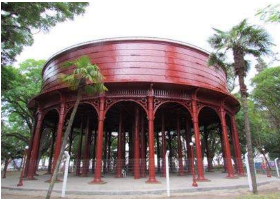
Ilustração 05 – Vista frontal do Reservatório R1.
