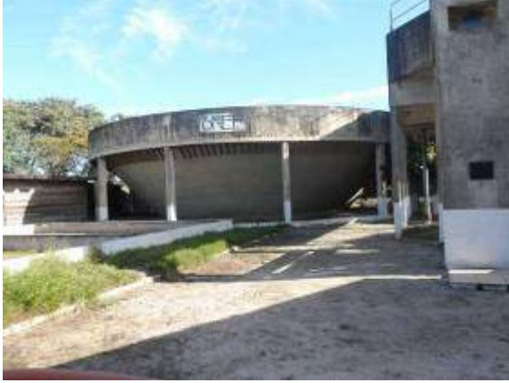
Elevatória US-III - RALF. (Fonte SANEP)
