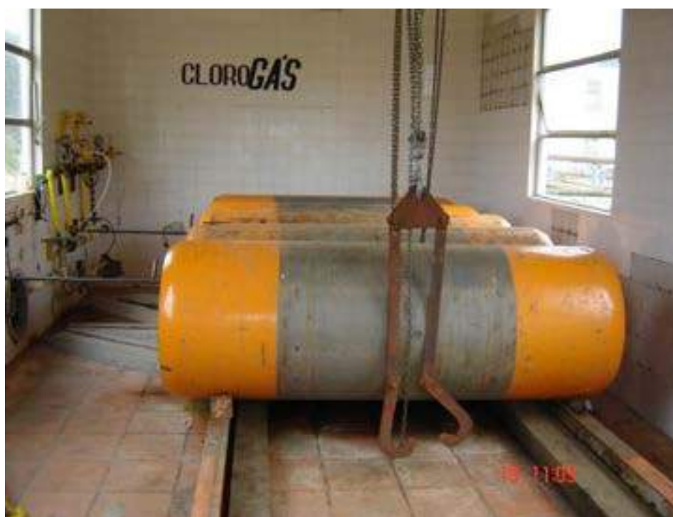
Ilustração 45 - Cilindros de cloro
