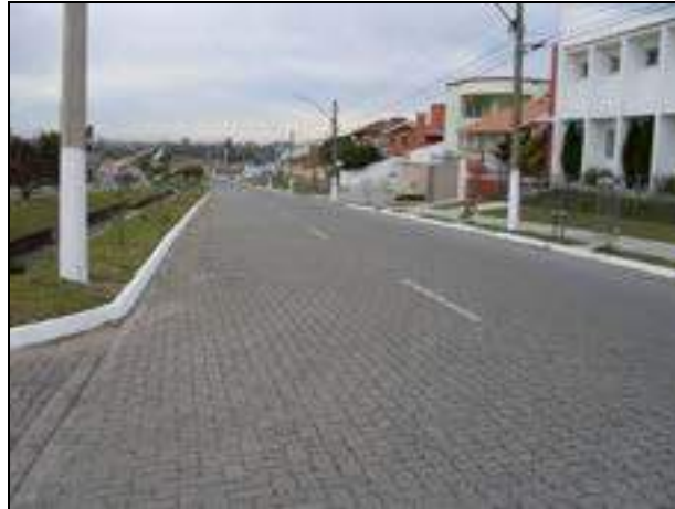
Figura 3.31 – Meio-fio após serviço de pintura
