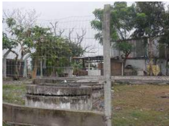
Entrada da ELE – Ceval. (Fonte SANEP)
