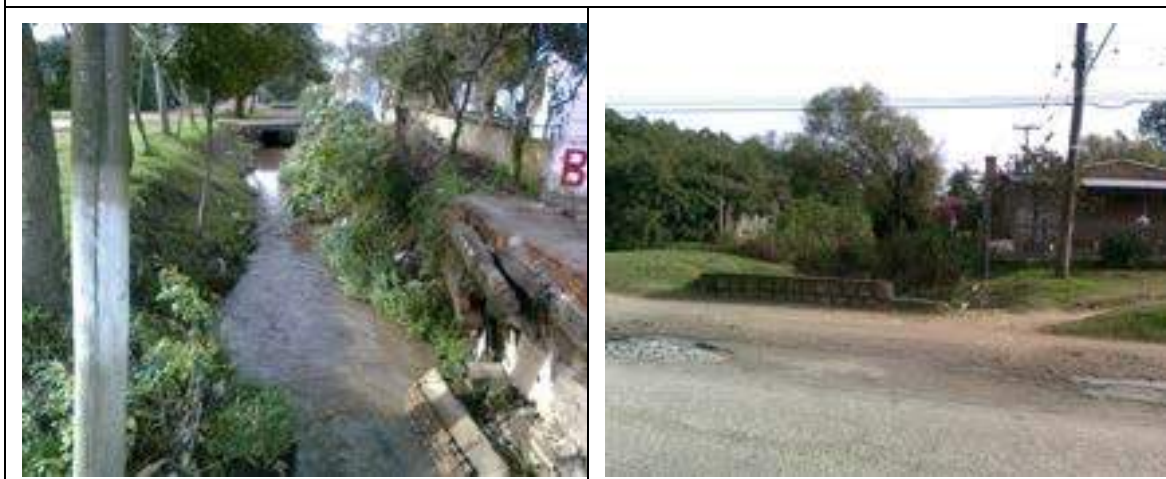
Figura 19: Avenida Domingos de Almeida - Obelisco
