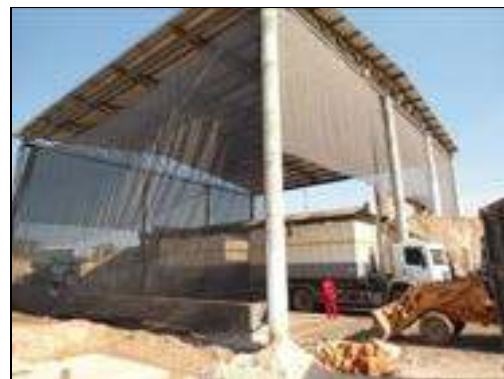
Figura 5.18 – Vista do transbordo
