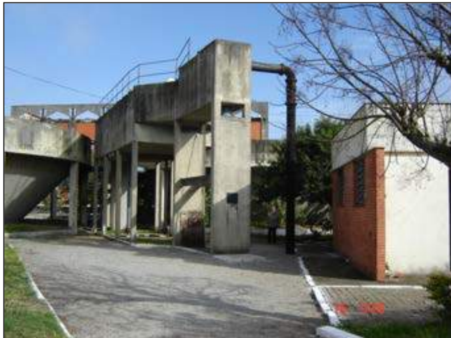
Figura 15 - Vista da estrutura de entrada (desarenador e Calha Parshall), com os dois reatores ao fundo. (Fonte STE)
