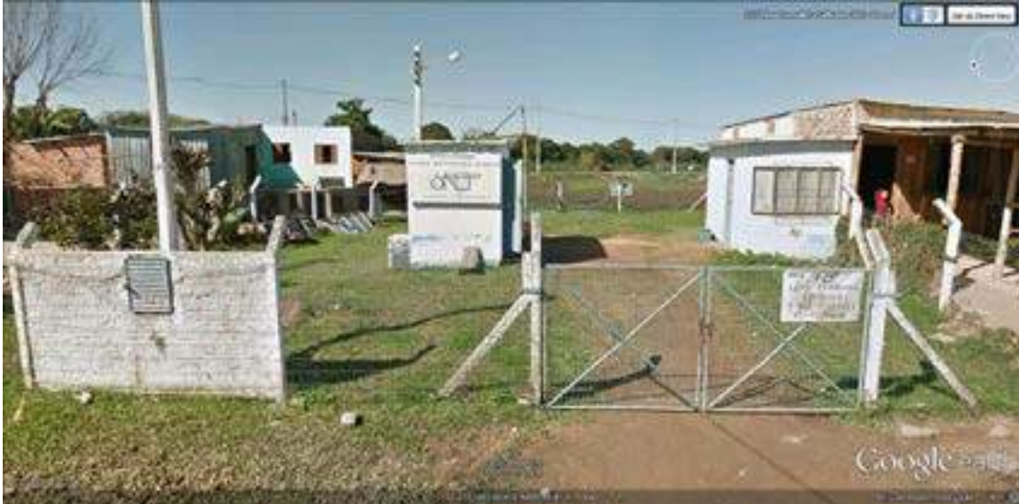
Local da Elevatória Rodoviária (ELE CG-2) - (Fonte Google)
