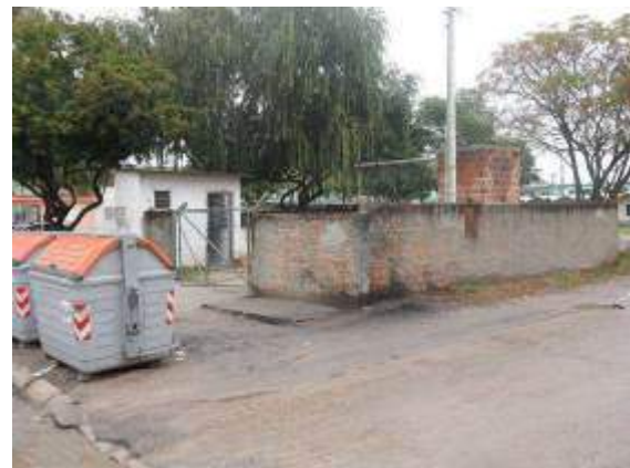
Quadro de comando ELE – Guabiroba. (Fonte SANEP)
