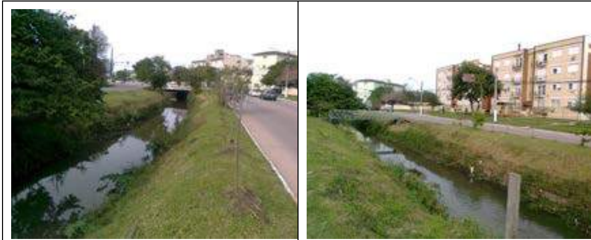
Figura 20: Avenida Juscelino Kubitschek - Arroio Pepino, ponto crítico de alagamento.
