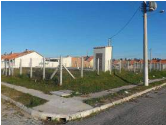
Local da Elevatória Eldorado. (Fonte SANEP)
