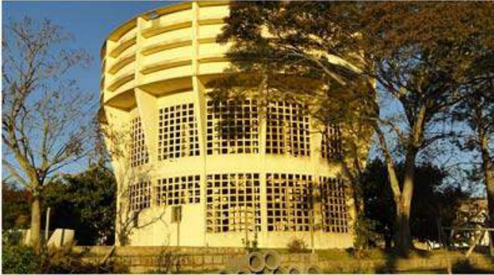
Ilustração 011 – Vista geral do Reservatório R-3.
