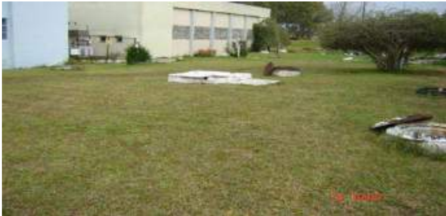
Ilustração 41 - Local onde estão os reservatórios enterrados R6, R61 e R62
