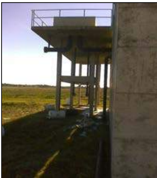
Figura 26 – Desarenador (Fonte STE)
