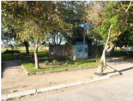
Local da Elevatória Ambrósio Perret. (Fonte SANEP)
