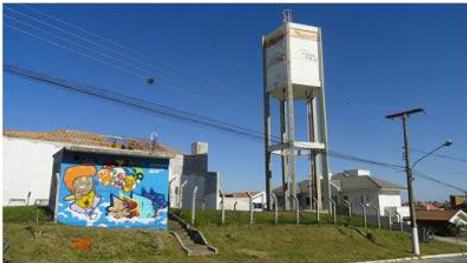
Ilustração 016 – Vista frontal do Reservatório localizado no bairro Colina do Sol.
