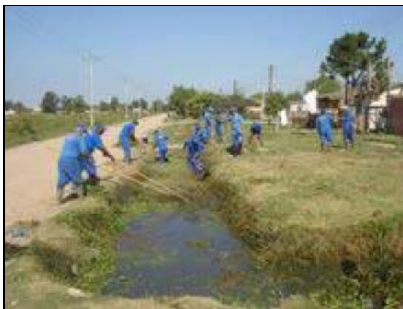
Figura 3.33 – Limpeza de valetas
