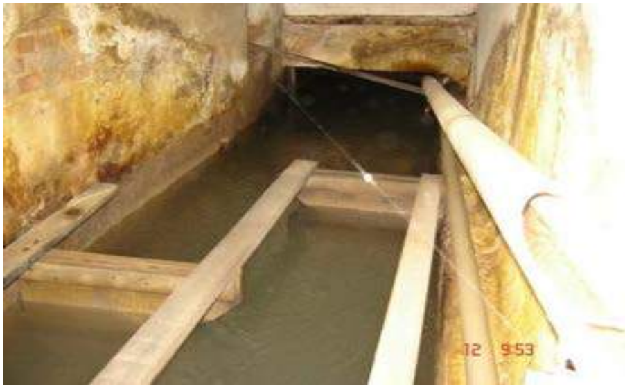
Ilustração 6 – Calha de mistura com chicanas
