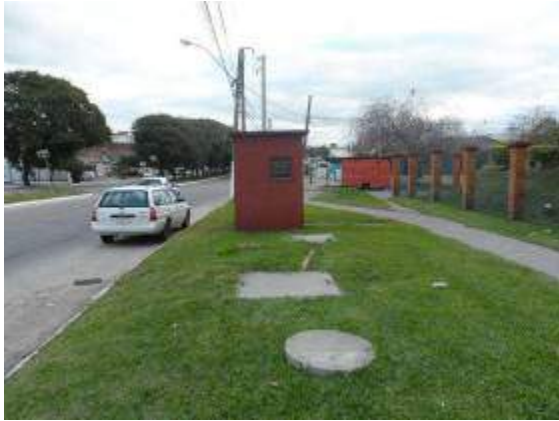
Local da Elevatória Ferreira Viana. (Fonte SANEP)
