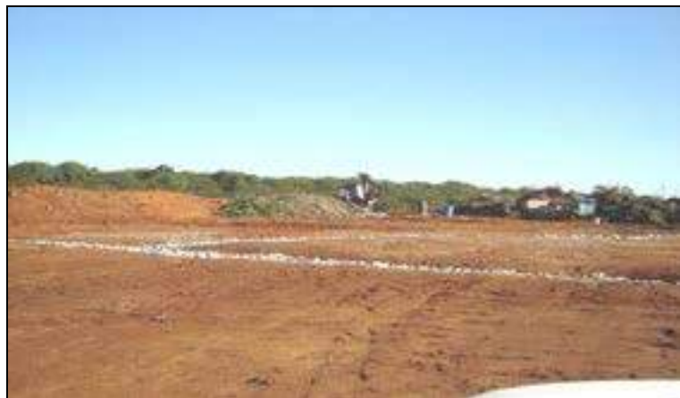
Foto 3.5 – Lançamento do sistema de drenagem de chorume
