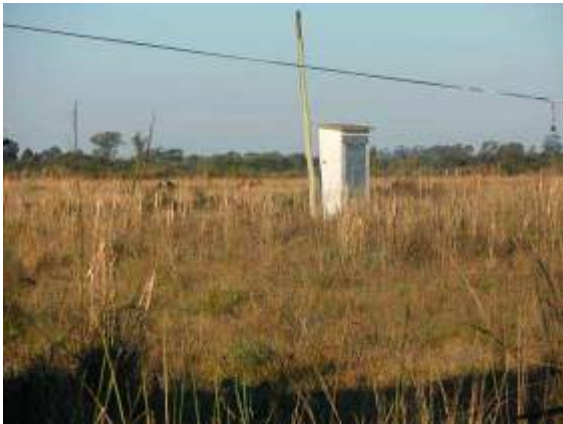
Local da Elevatória Ceval. (Fonte SANEP)
