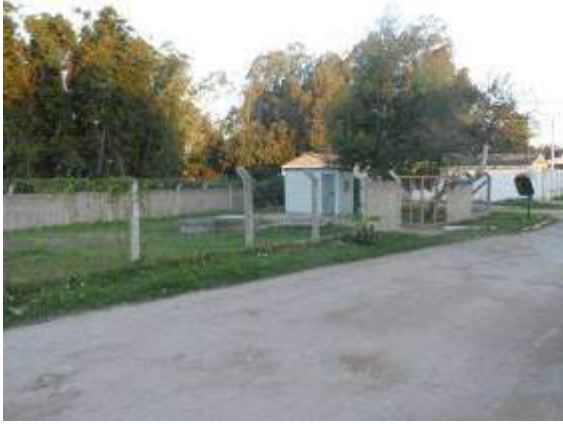
Local da Elevatória Cohab Fragata. (Fonte SANEP)
