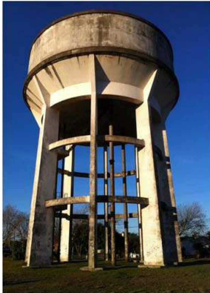
Ilustração 010 – Vista frontal do Reservatório R10.
