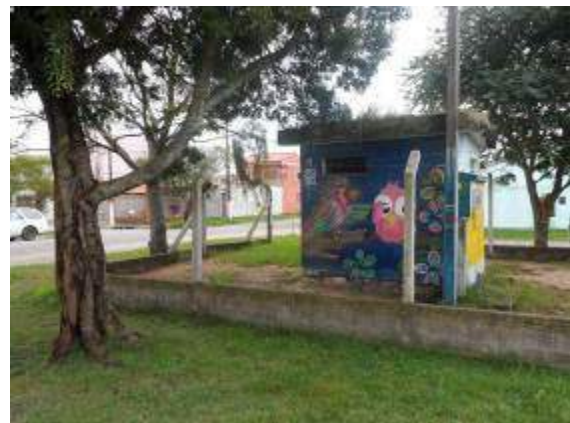
Quadro de comando ELE – Umuharama. (Fonte SANEP)
