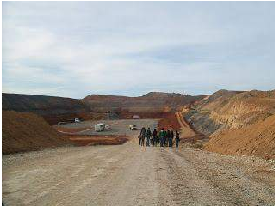
Figura 3.42 – Vista do aterro sanitário Candiota
