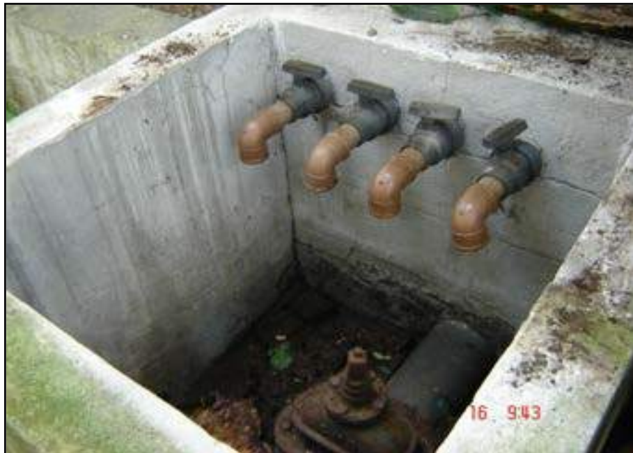
Figura 22 - Expurgo do lodo excedente para secagem (Fonte STE)
