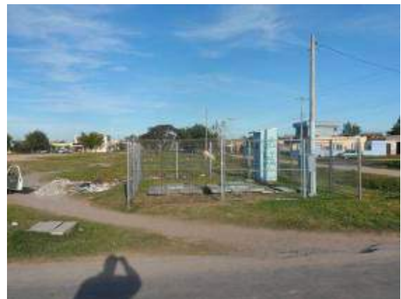
Quadro de comando ELE – Meneghetti. . (Fonte SANEP)
